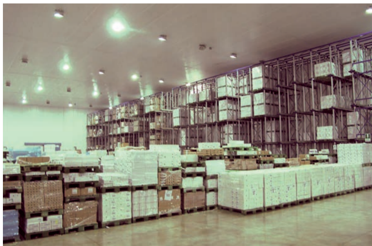
Con l'integrazione della soluzione Di.Tech per la digitalizzazione DeliveRing, Conad ha potuto svincolare completamente la propria catena informativa dalla carta
